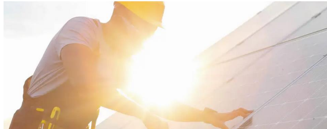
Planification d'installations solaires sur les bâtiments communaux
